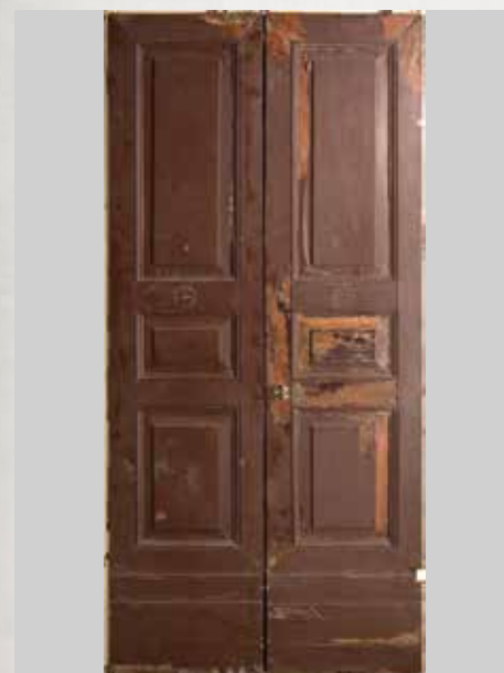
Prima del restauro.
