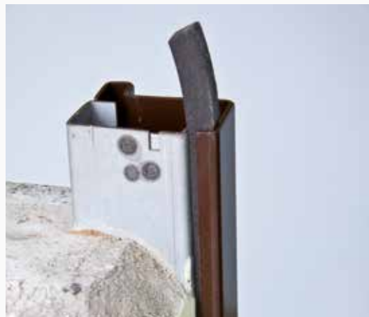
GUARNIZIONE TELAIO MURO inserita all'interno del telaio.
